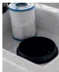
4. Vyměňte starý filtr a vložte nový; poté zopakujte předchozí kroky
